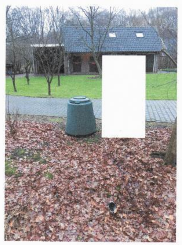
Foto van afvoer hemelwater in sloot op het perceel
