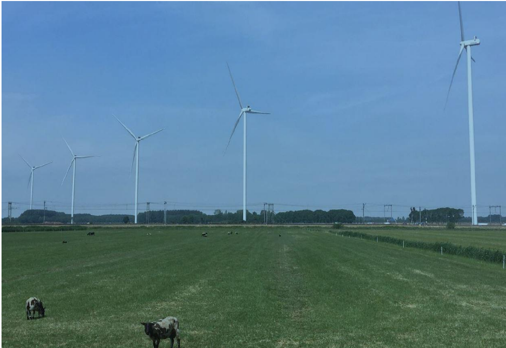
Afbeelding 7. Opstelling bij Deil in de Betuwe van Vestas V136 molens met een vermogen van 4,2 MW. De ashoogte is 140 meter, de rotordiameter is 136 meter, de tiphoogte is: 140 + (136/2) = 208 meter.
