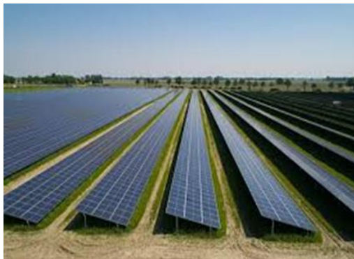
Afbeelding 4: zonnepanelen in een oost-west opstelling
